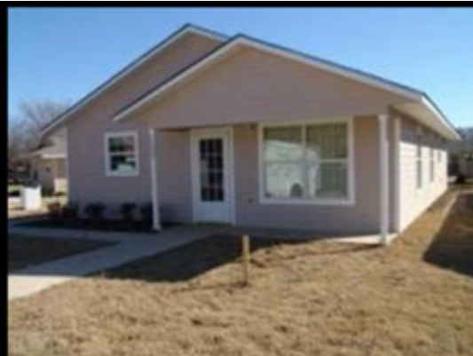
Standardowa budowa HfH Energy Star Izolacja watą szklaną 14 poziom SEER*, klimatyzacja, oświetlenie standard.
