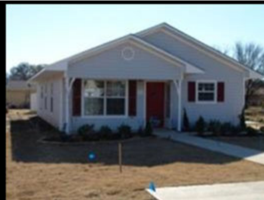
Standardowa budowa HfH Energy Star Izolacja pianką Sealection 500 19 SEER, klimatyzacja, oświetlenie: w 60% świetlówki
